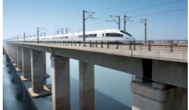
BETONJAVÍTÁS ÉS SZERKEZETMEGERŐSÍTÉS
