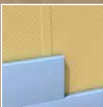
WT védőlemez/ geotextília és hőszigetelő táblák
