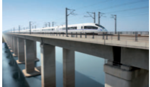
BETONJAVÍTÁS ÉS SZERKEZETMEGERŐSÍTÉS
